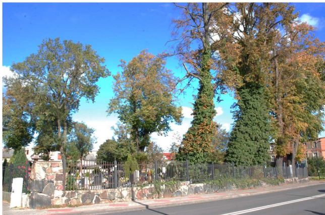
Widok od strony południowej.
