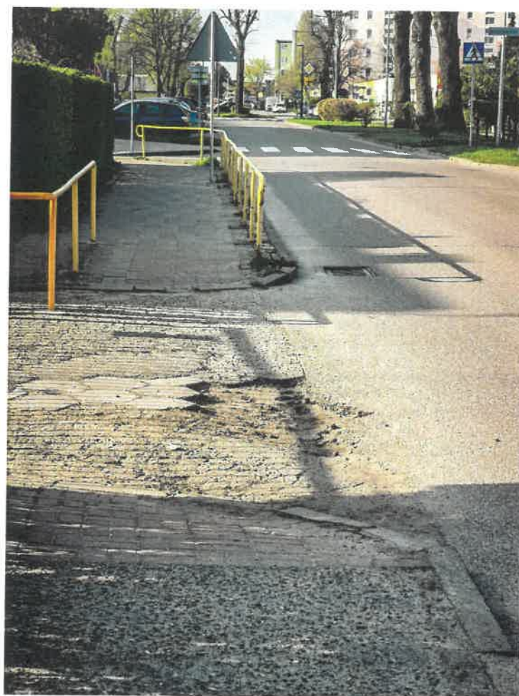
Załącznik nr 1 - dziura w nawierzchni przy al. Lipowej
